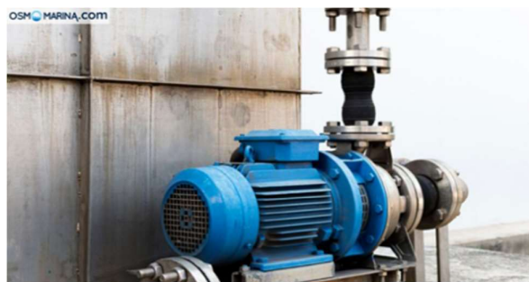
Gambar 2. 14 Ejector Pump Sumber: osmo marina (2023)
