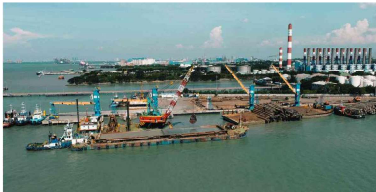
Gambar 1. 1 Dermaga Talud Tegak
