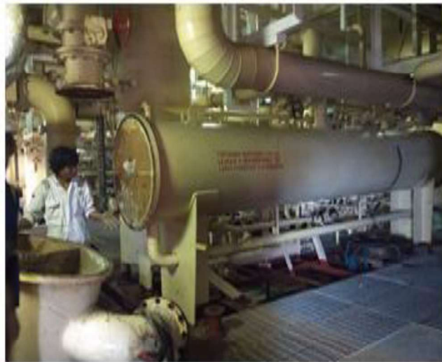
Gambar 2. 2 Cargo Condensor LPG/C SMB II Sumber : Dokumen kapal (2024)
