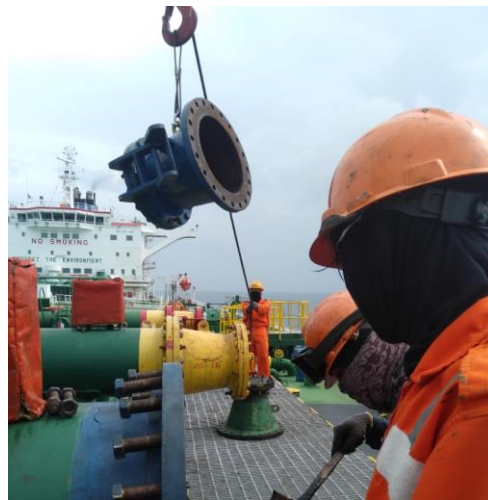
Gambar 2.1 Proses Pergantian Reducer pada Manifold Sumber: Dokumentasi Pribadi
