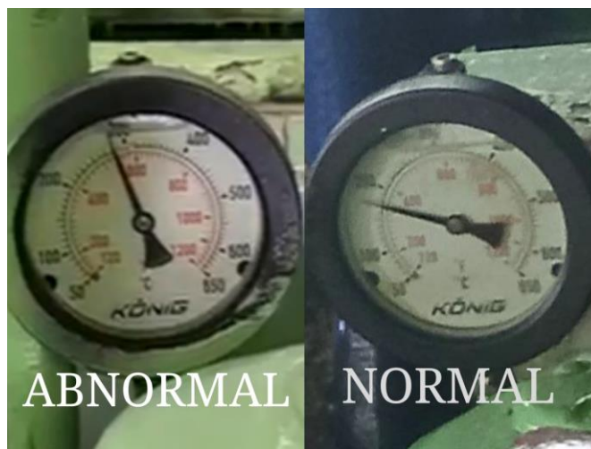
Gambar 4. 16 Perbedaan Gas Buang Normal Dan Abnormal Sumber : Dokumen Penelitian (2023)
