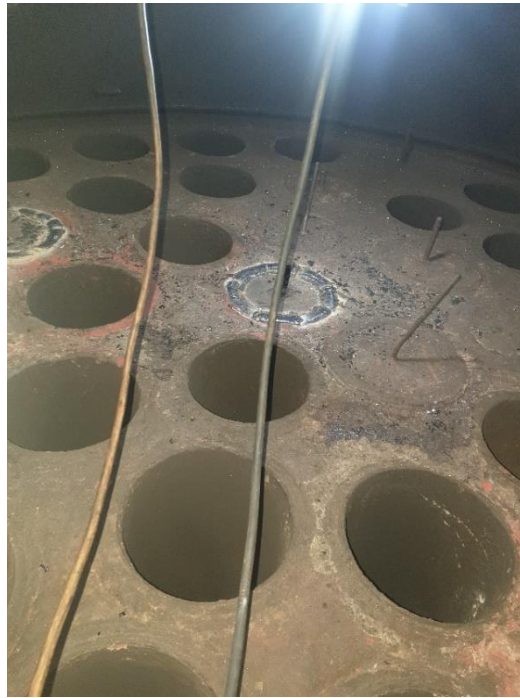
Gambar 2.7 Manhole Boiler Sumber : Dokumentasi dari kapal MT.Sindang
