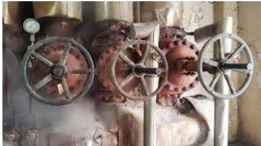
Gambar 2.3 Katup Utama ( Main Steam Valve ) Sumber : Dokumentasi dari kapal MT.Sindang
