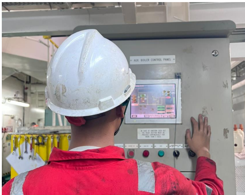
Gambar 4. 4 Pengecekan sistem pembakaran pada panel Sumber : Dokumentasi pribadi (2021)
