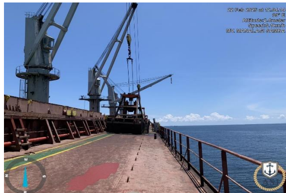
Gambar 2. 4. Pemeriksaan Crane Sumber : Dokumentasi Pribadi
