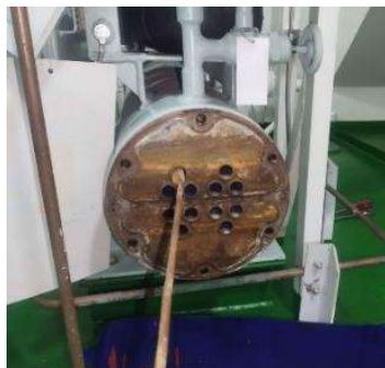
Gambar 2.6 Pembersihan pada Kondensor
