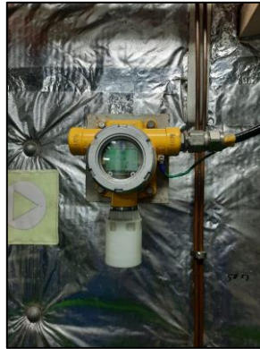
Gambar 2. 2 Pemasangan Sensor XCD di dalam kamar mesin Sumber : Dokumen Pribadi
