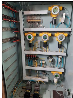
Gambar 2. 1 Komponen Fix Gas Detector Hanla IMS dalam Panel Sumber : Dokumen Pribadi
