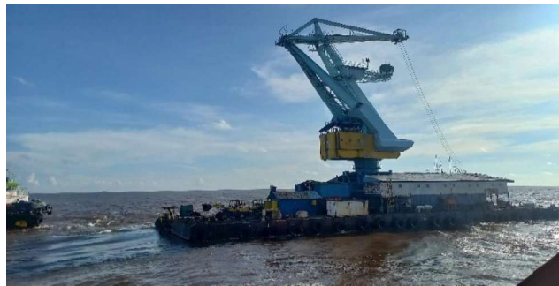
Gambar 2. 3. Floating Crane Sumber : Dokumentasi Pribadi
