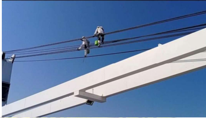
Gambar 2. 1 Pelumasan Wire crane
