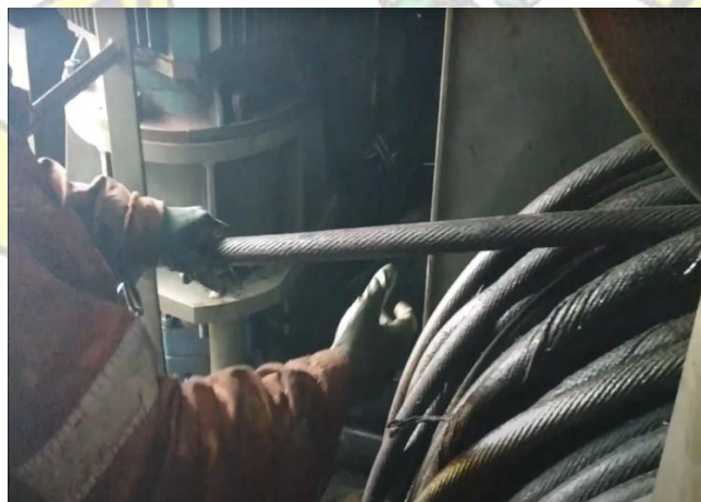
Gambar 2. 2 Pelepasan Wire Lama
