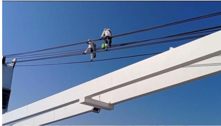
Gambar 2. 1 Pelumasan Wire crane
