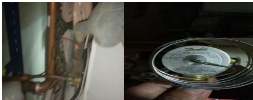
Gambar 2. 5 Katup Expansi Sumber : Dokumen Penulis (2022)
