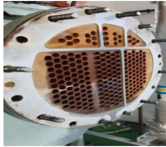
Gambar 2 2 Condensor Sumber : Dokumentasi Pribadi
