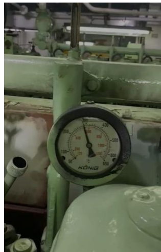
Gambar 4. 15 Temperatur Gas Buang setelah dilakukan perbaikan Sumber : Dokumen Peneliti (2023)
