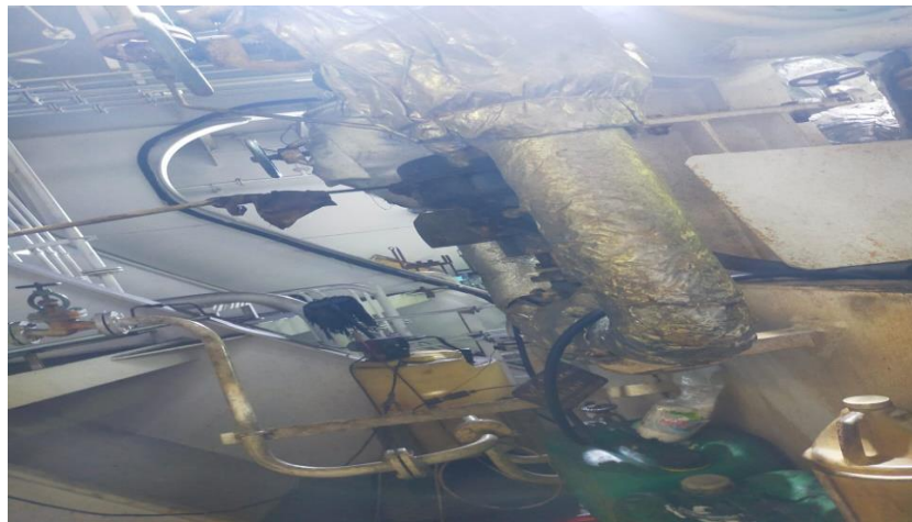
Gambar 1. 1 Tangki Cascade (Sumber : Dokumentasi Pribadi, 2023)
