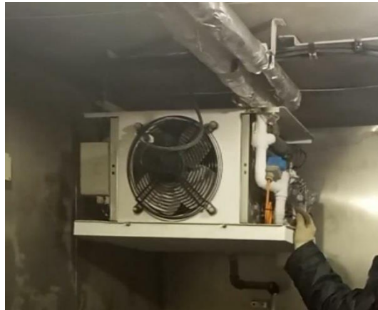
Gambar 2. 10 Fan Motor
