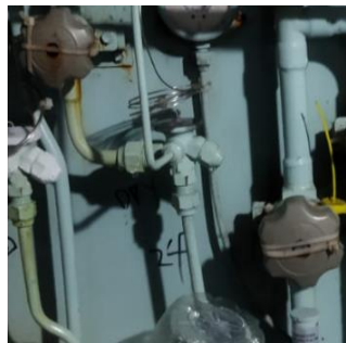
Gambar 2. 3 Katup Ekspansi Sumber : Dokumentasi Peneliti
