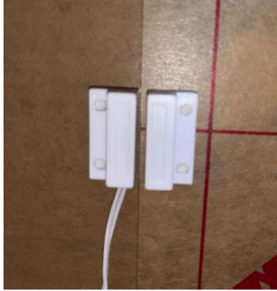
Gambar 4. 5 Pemasangan Reed Switch Sumber: Dokumen Pribadi (2025)
